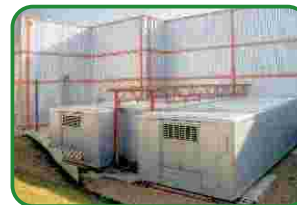
Sistema costituito da celle frigorifere modello SB27 e da un surgelatore modello MidiBlast collocato su un rialzo in cemento appositamente disegnato.
