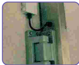
Cerniere rinforzate, elementi riscaldanti all'interno delle guarnizioni delle porte
