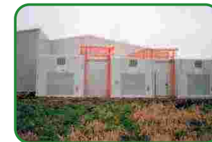
3 celle frigorifere combinate ad altezza maggiorata con isolamento acustico supplementare.
