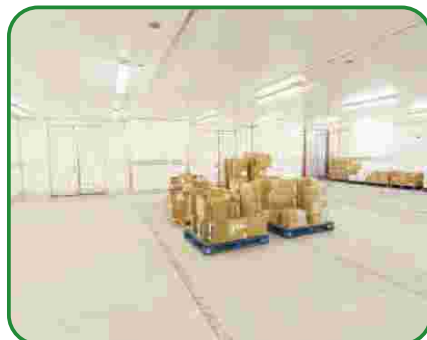
5 celle frigorifere modello SuperBox combinate, equipaggiate con impianto di illuminazione e unità di refrigerazione supplementari.
