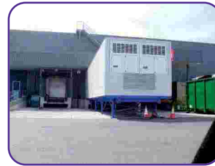
Struttura di messa a livello
